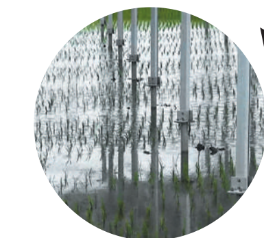
スクリー杭と浮沈防止ベースによる支柱
