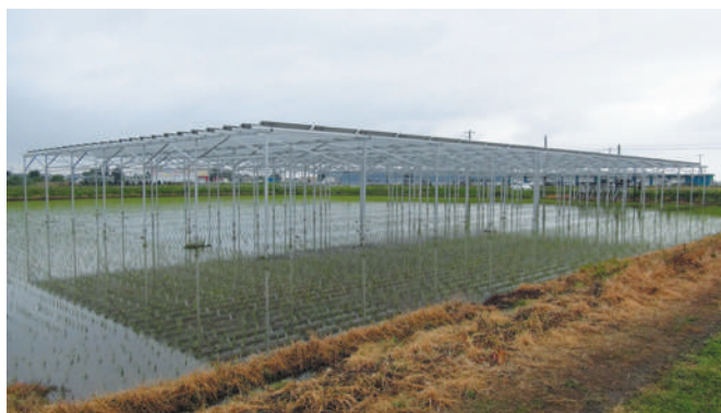
スクリー杭と浮沈防止ベースによる支柱
