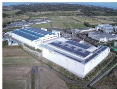
ドローンによる通常撮影
