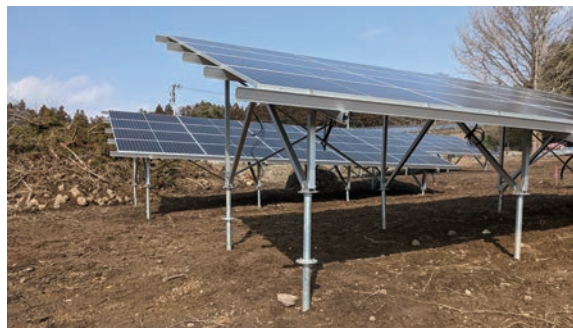
被せフランジ（施工例）
