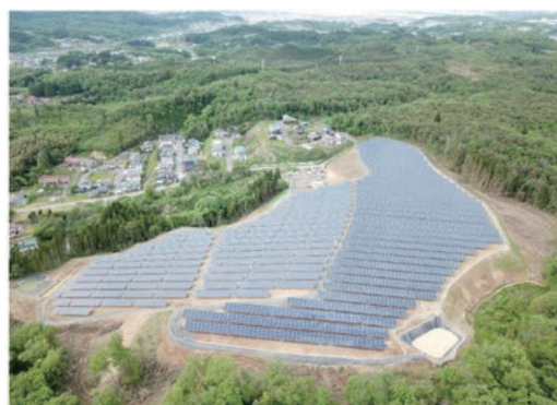
高圧太陽光発電所/岩手県一関市/自社物件 (株)アジアインフォネット所有/2,541kW/2018年5月連系
