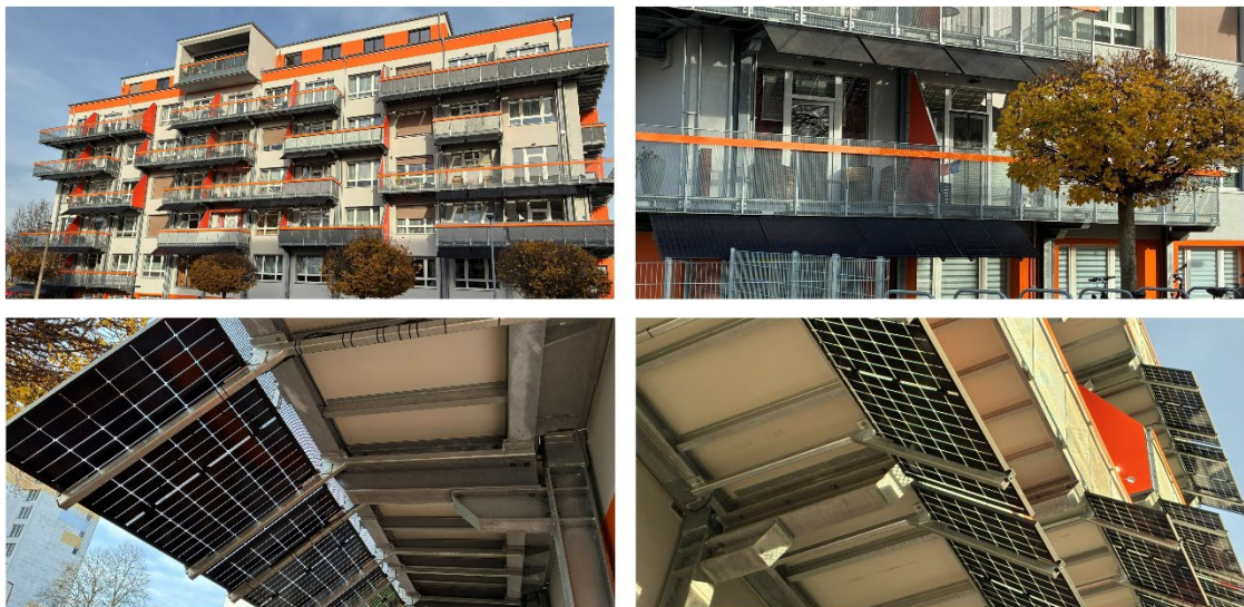
図 14：ドイツ・ゼメルダのプラグインソーラー実証プロジェクト
