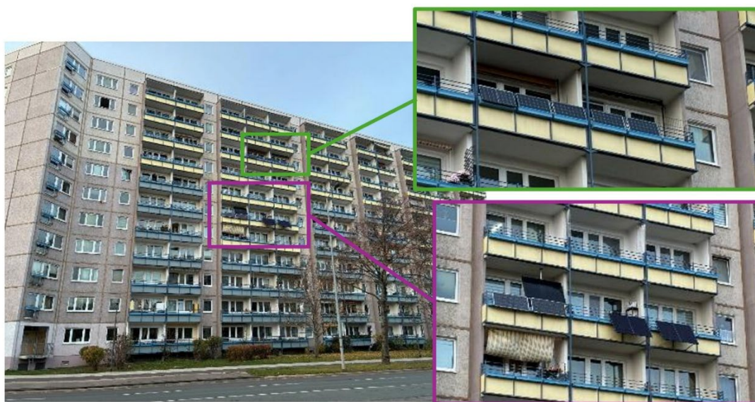
図 11：ドイツの大規模集合住宅に設置されたプラグインソーラー
