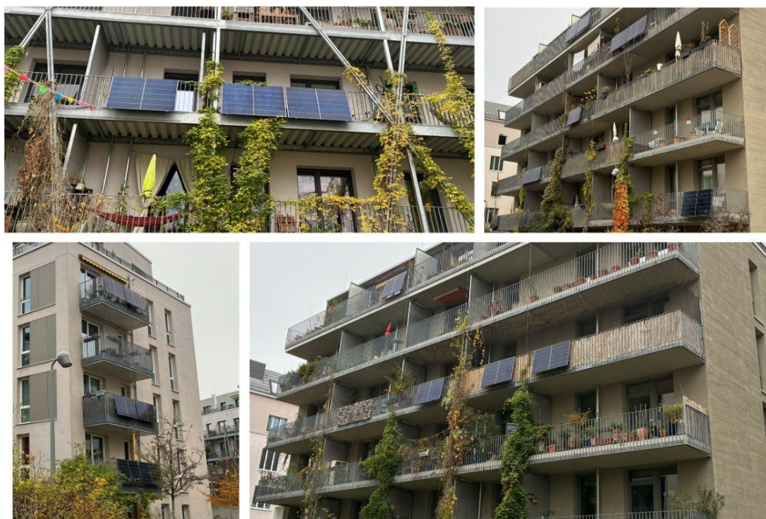
図 12：ドイツ・ベルリンの Möckernkiez に設置されたプラグインソーラー
