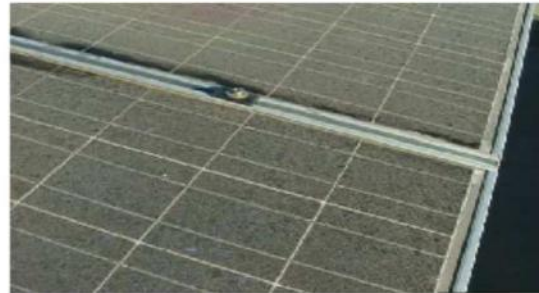
図1: 時間経過に伴ってパネルに積もった埃の例
