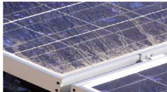
図2: 埃がパネルに落ちている例
