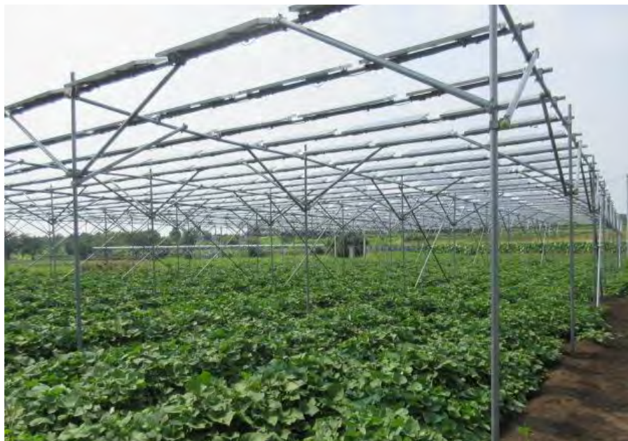
露地の畑の上部にパネルを設置
