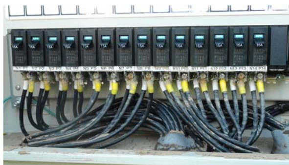
図 4.R3.3-4 端子台下部の汚れ(接続箱#07)
