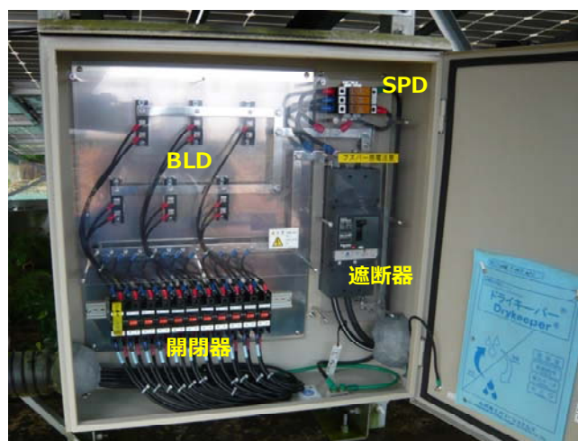
図 4.R2-5 接続箱内部の様子
