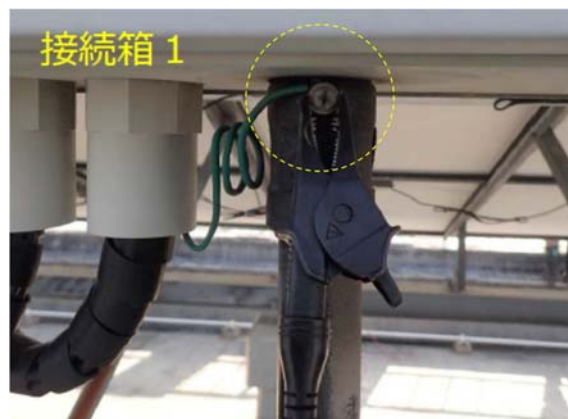
図 4.R3.10-1 接続箱#01 の接地極
