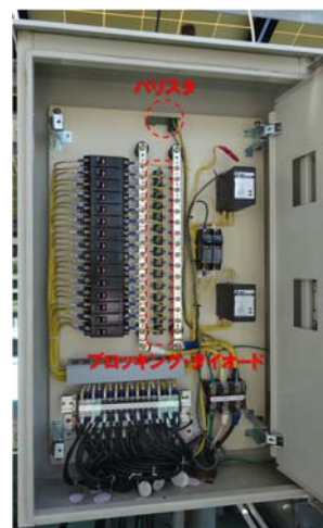
図 4.R3.8-1 接続箱#01 の内部の様子
