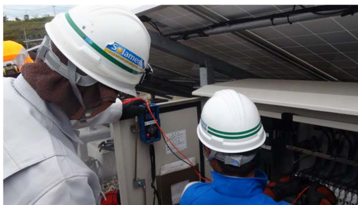
図 4.R3.6-15 ソラメンテ Z によるインピーダンス測定
