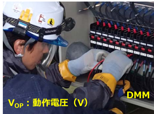
(a)動作電圧の測定
