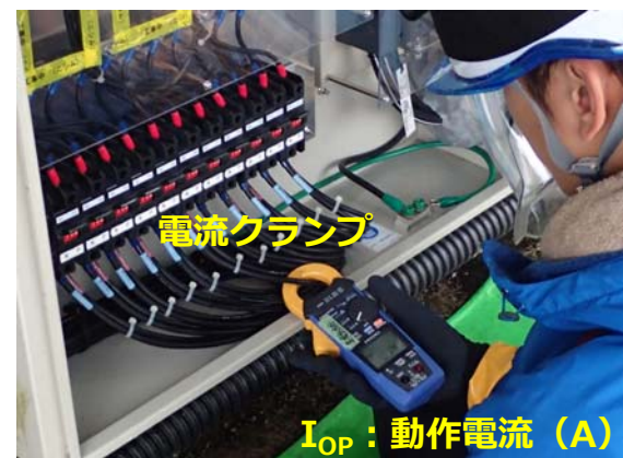
(b)動作電流の測定
