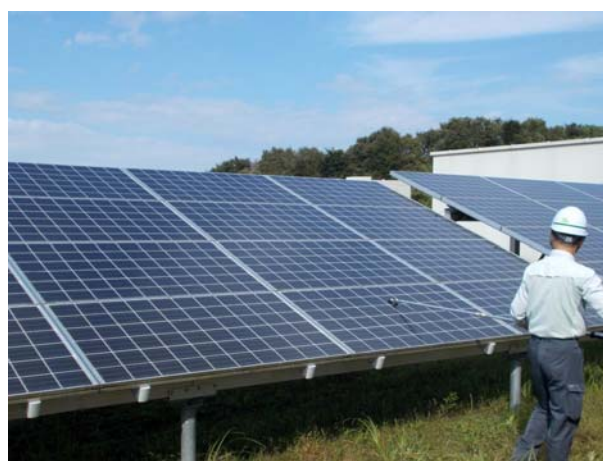
図 4.R2-19 ソラメンテ iS による BPC 短絡故障の検査
