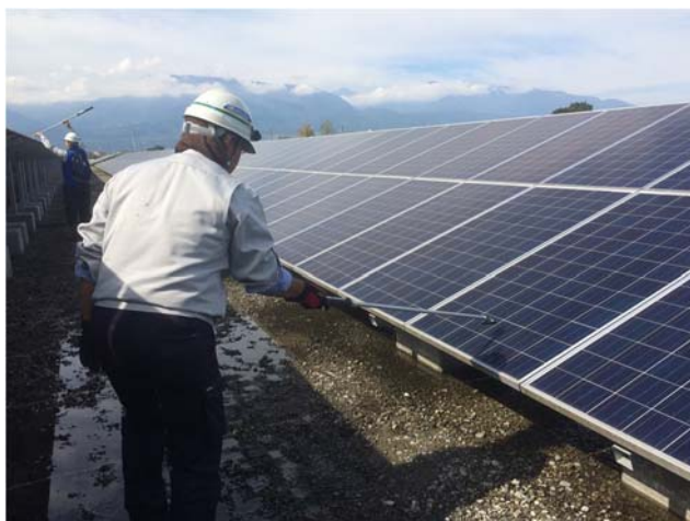
図 4.R3.6-25 ソラメンテ iS による電流探索
