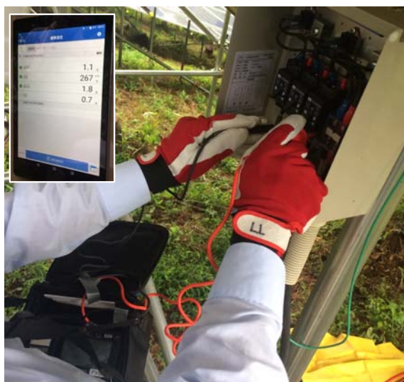
図 4.R2-22 バイパスダイオードテスタ (日置電機)
