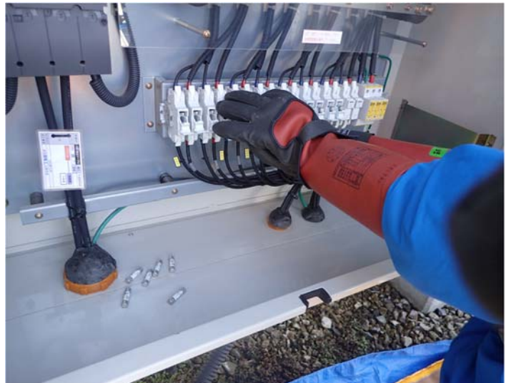
図 4.R3.6-23 ヒューズを取り外している様子
