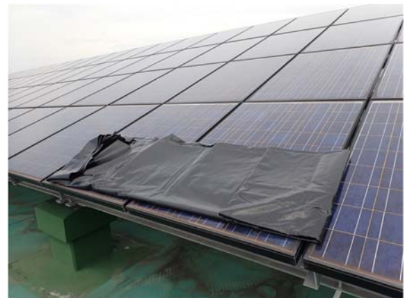
図 4.R3.8-3 モジュールを遮光している様子
