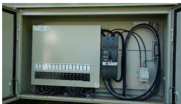
図 4.R3.3-1 接続箱の外観と内部(外蓋を開けたあと)の様子
