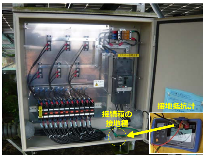
(b) 接続箱内接地極への接地抵抗計の接続
