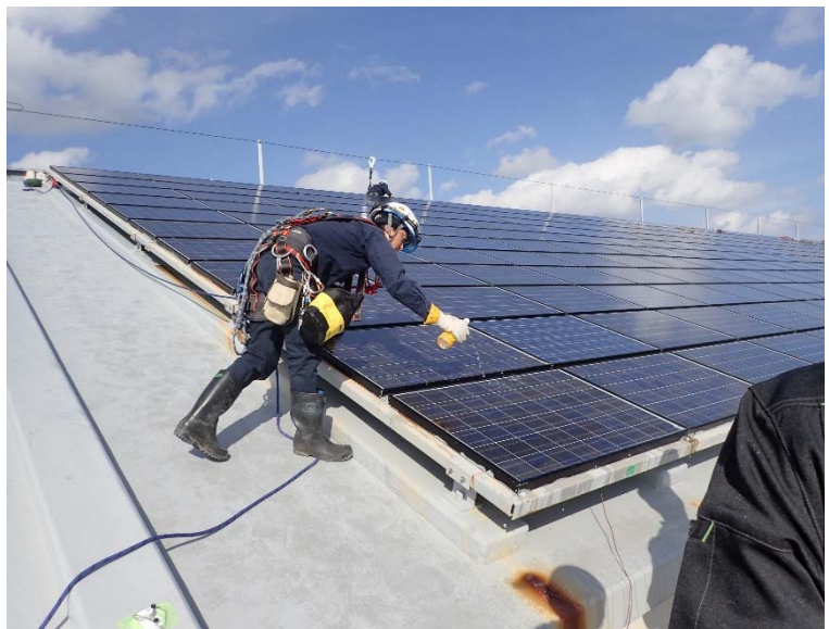
図 4.R3.4-6 モジュールを水で濡らしている様子（ストリング#01-01）
