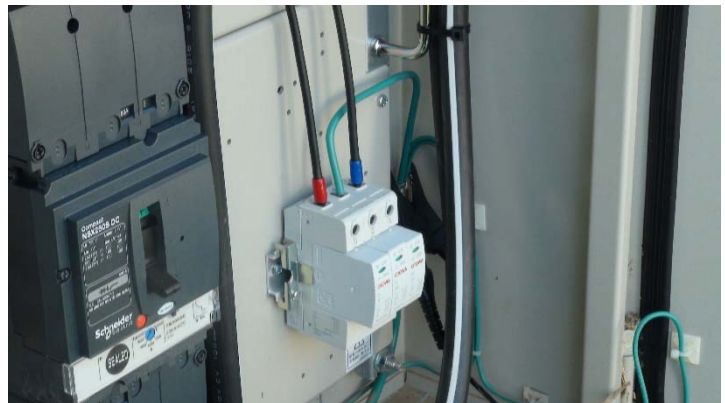
図 4.R3.3-7 接続箱内の接地極(接続箱#07)
