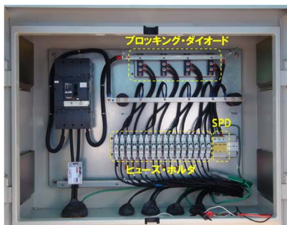
図 4.R3.6-1 接続箱(8 String用)内部の様子
