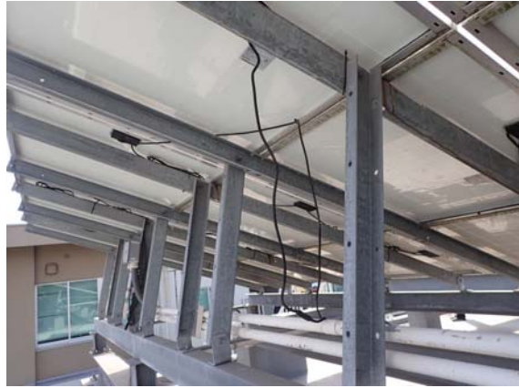
図 4.R3.9-9 結束バンドが切れて垂れ下がるモジュールケーブル
