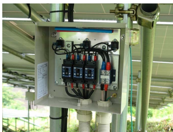
図 4.R3.5-1 接続箱内部の様子
