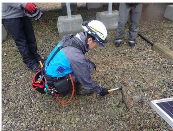
図 4.R3.6-3 補助極を打っている様子
