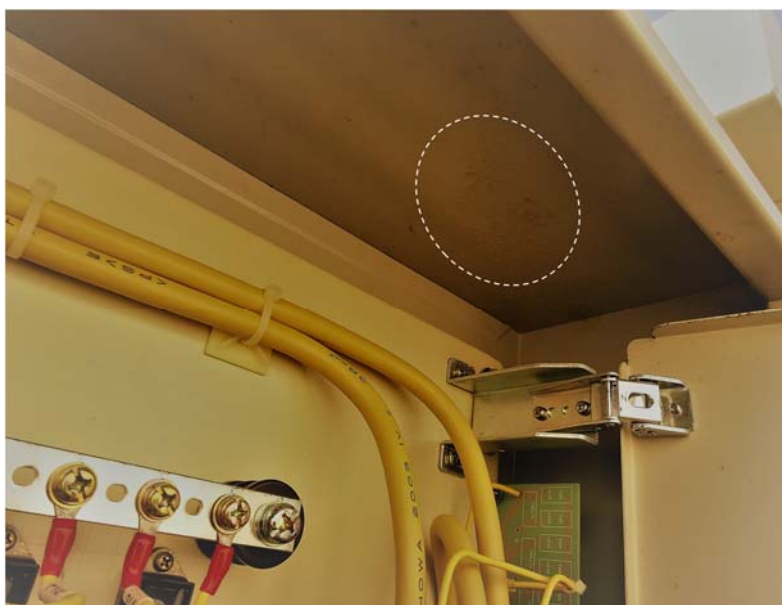
図 4.R3.4-1 接続箱#01 内部の様子 (破線内に水滴を確認)
