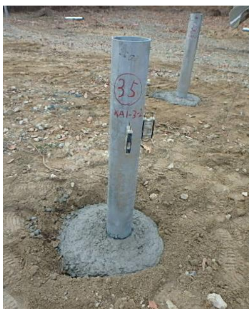
場所打ちコンクリート杭に鋼管杭埋設
