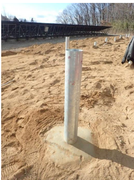
柱状改良杭に鋼管杭埋設
