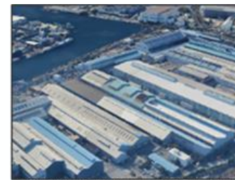
南地区の既設工場建屋群
