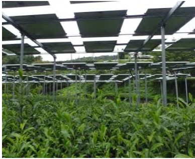
設置された太陽光パネル
