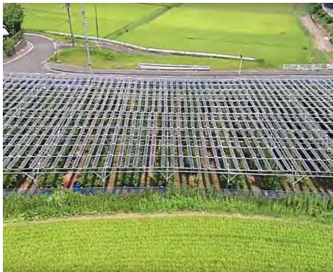
発電施設の外観
