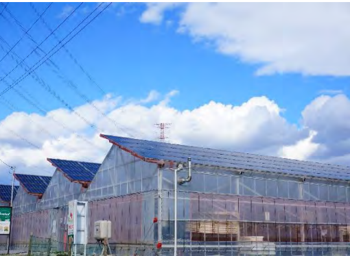
発電施設の外観
