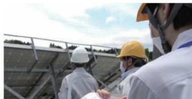
太陽光パネルの検査
