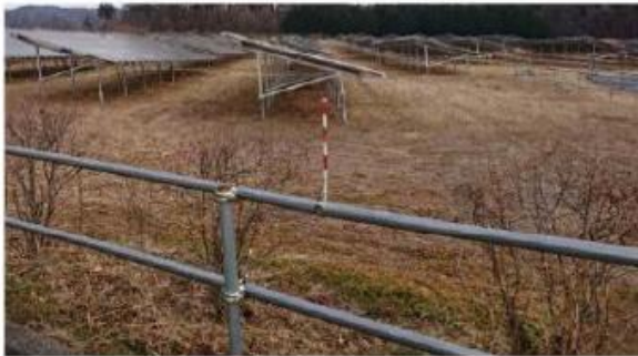
金属パイプの間から入ろうと思えば第三者が容易に設備内に立ち入られる
