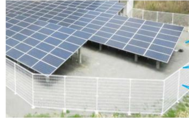
<適切な柵塀設置の事例>
