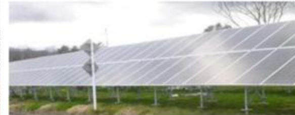
柵がなく容易に侵入出来る
