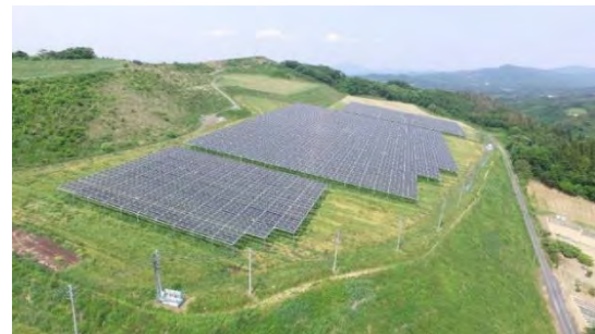
発電設備の外観（吉高地区）
