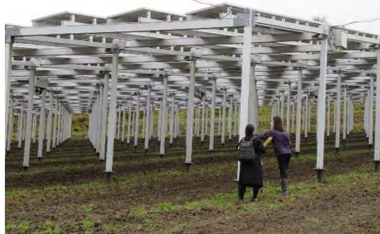
支柱高3.5m、間口6mで設計
