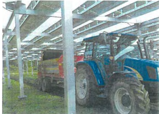
大型機械も作業可能
