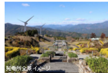
大豊風力発電所（高知県長岡郡大豊町）
