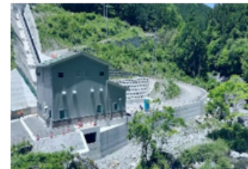
黒藤川水力発電所（愛媛県上浮穴郡久万高原町）
