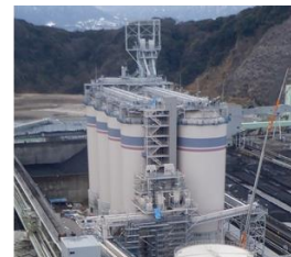
敦賀火力発電所燃料貯蔵サイロ
