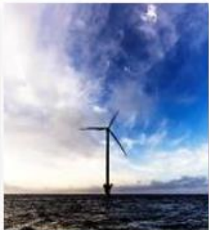
銚子沖 洋上風力発電所
