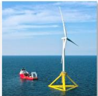
ノルウェー沖 浮体式洋上風力発電実証機
