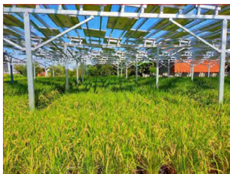
地区②の発電設備の外観
