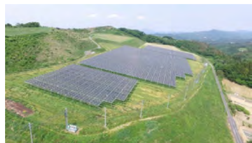
発電設備の外観（吉高地区）
