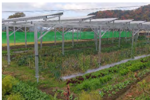
発電設備の外観
