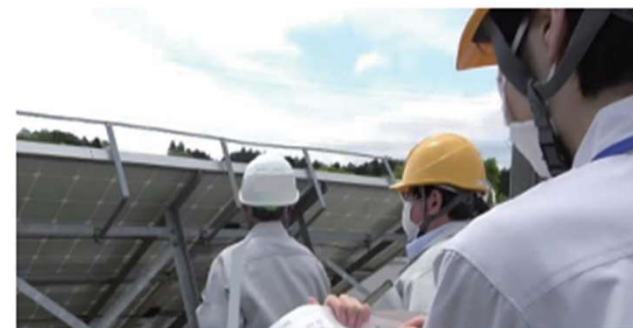
太陽光パネルの検査
