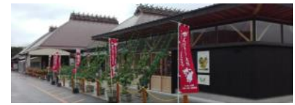
■道の駅うきは (奥：物産館、手前：ギフトコーナー)
