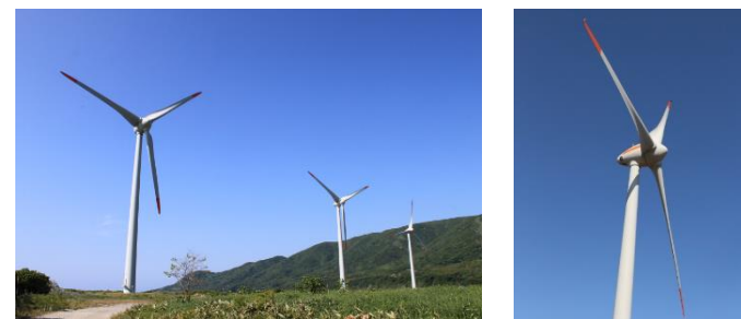
寿都町 風力発電施設
