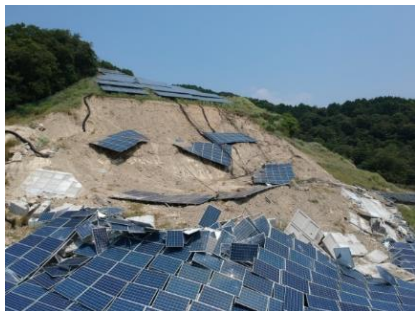
土砂崩れで生じた崩落
