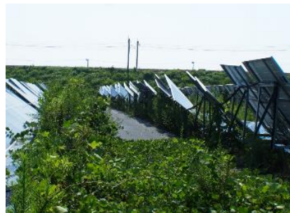
不十分な管理で放置されたパネル
