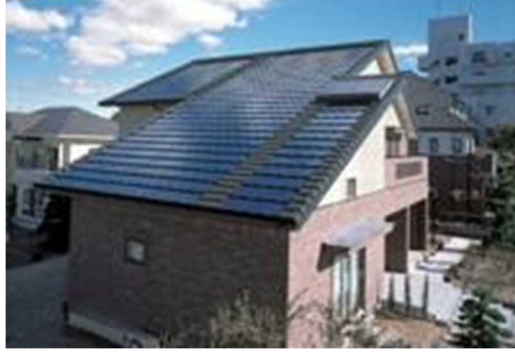
図表 11 屋根置き型太陽光発電システム例
