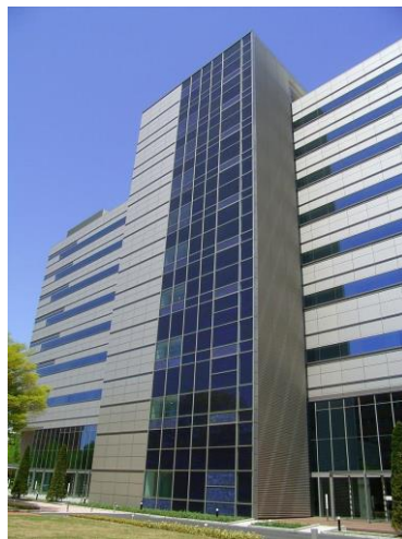
写真 1-1 壁面設置 PV の事例 出典:産業技術総合研究所
