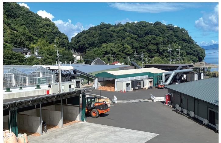
木質バイオマス熱電供給プラント及び周辺施設
