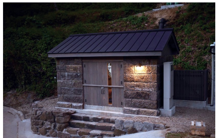
石積みの発電所建屋
