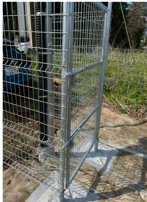
2.扉を設置・完成
