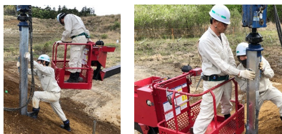
(b) 型鋼杭の施行令例（打撃貫入）
