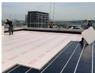
公共施設等のZEB化 （屋根の高断熱化・複層ガラスの導入）
