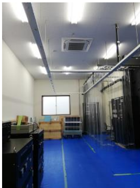
図 5-17 ソーラシミュレータの電源上部へのエアコン設置
