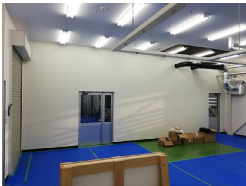
図 5-15-1 断熱壁による施設中央の間仕切り
