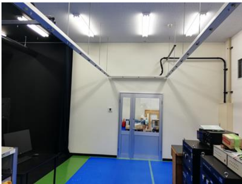
図 5-15-2 断熱壁による施設中央の間仕切り
