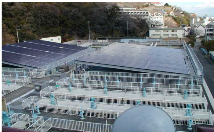
神戸市 奥平野浄水場
