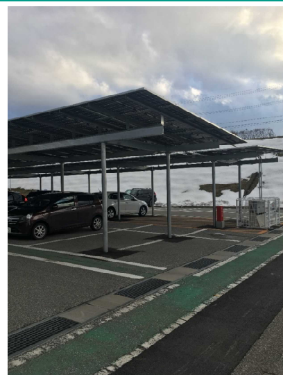
写真 ソーラーカーポート設置状況
