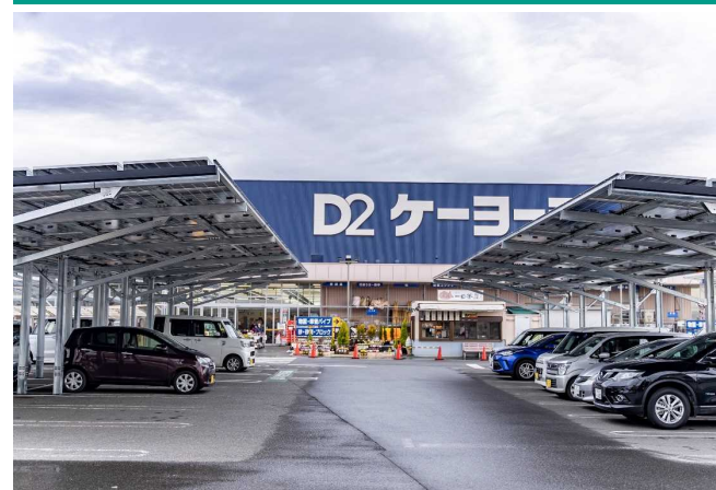
写真 ソーラーカーポート設置状況
