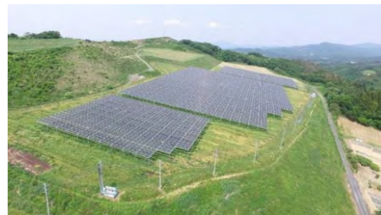
発電設備の外観（吉高地区）
