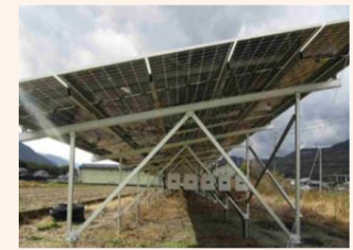
営農型太陽光発電で下部農地での生産がほとんどされていない
