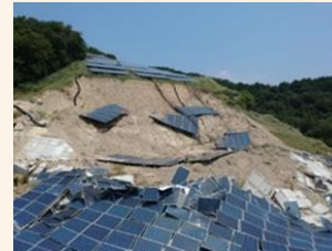
土砂崩れで生じた崩落
