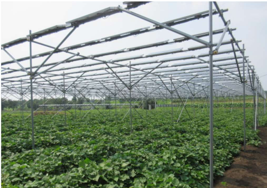
露地の畑の上部にパネルを設置
