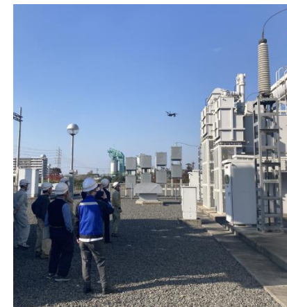
写真2 施設見学研修会 （中部電力PG 寛政変電所）
