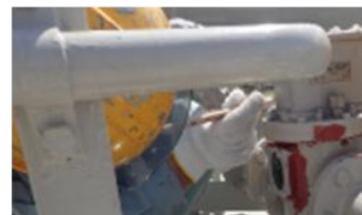
充電部近傍での作業 送配電設備に関する知識
