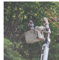
高所・充電部近傍での作業
