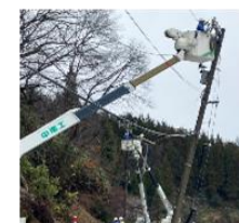
設備健全性に関する診断 高所・充電部近傍での作業 送配電設備に関する知識
