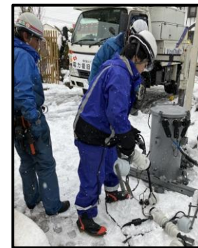
地震により破損した設備の復旧作業
