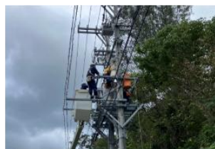
設備健全性に関する診断 高所・充電部近傍での作業 送配電設備に関する知識
