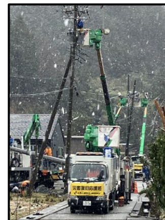
地震により傾いた電柱の建替作業
