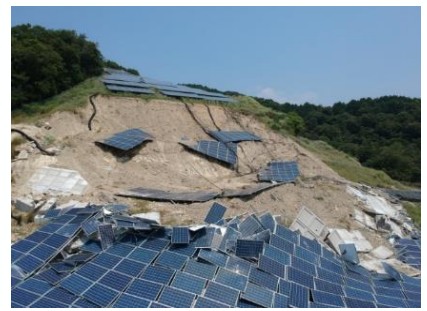
土砂崩れで生じた崩落
