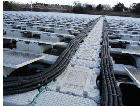
写真12-2 配管に納めた配線の例
