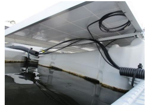
写真12-2 配管に納めた配線の例
