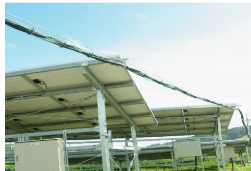
写真12-2 架空配線の例
