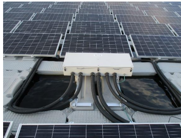
写真12-3 接続箱の設置例
