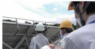
太陽光パネルの検査
