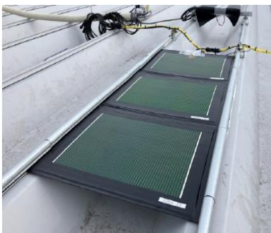
折板屋根への設置例
