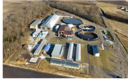
中鹿追バイオガスプラント
