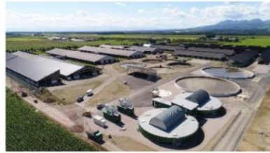
バイオガスプラント
