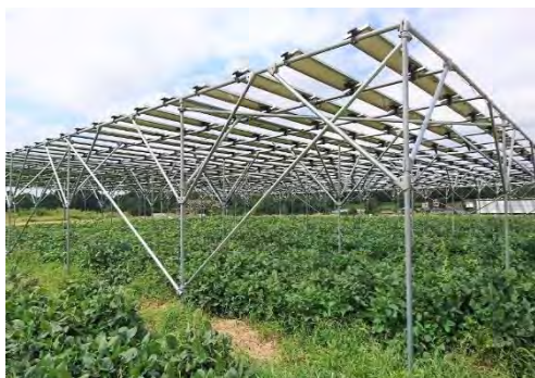
発電設備の外観
