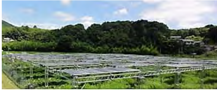
発電施設の外観
