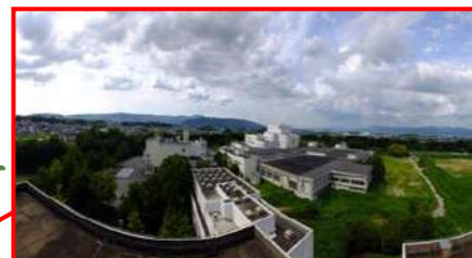
第二浄化センターへの太陽光発電設備の導入
