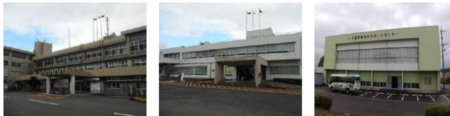
（左から）太陽光発電設備を導入予定の三股町役場、町立公民館、多目的スポーツセンター
