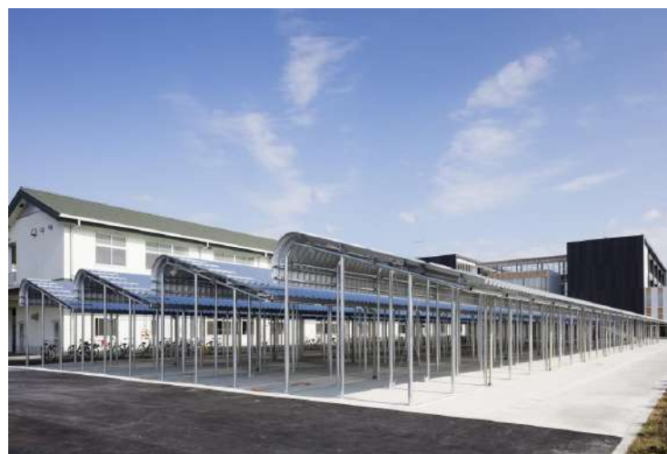
静岡県立浜松湖北高校 駐輪場（R6太陽光発電設備の導入(PPA)設置検討箇所）
