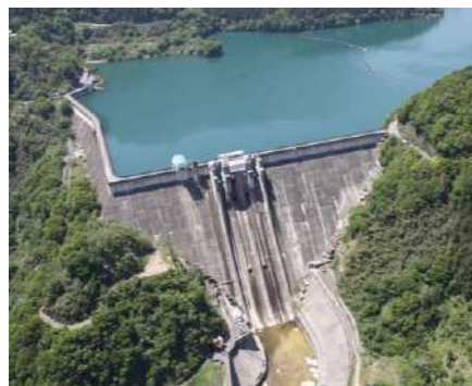
県内の水力発電所
