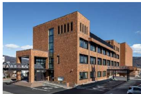
諏訪湖環境研究センターの施工事例
