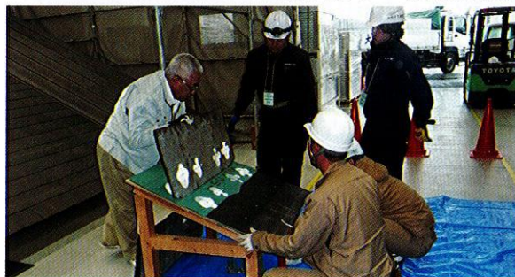
屋根を剥し充填結果を確認
