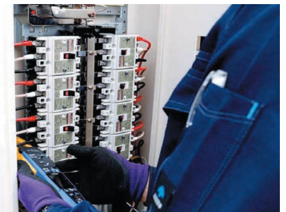
I-Vカーブトレーサー検査
