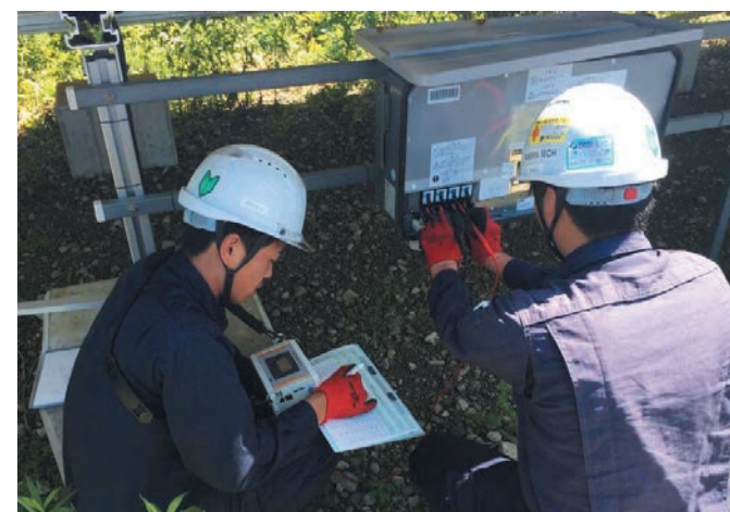
I-Vカーブトレーサー検査
